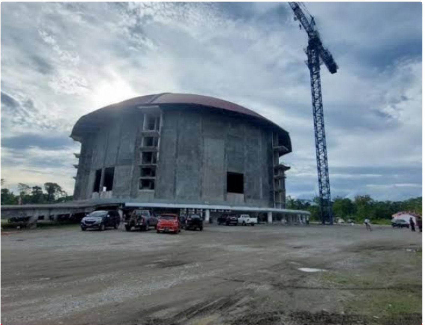
Pembangunan Gereja Kingmi Mile 32
